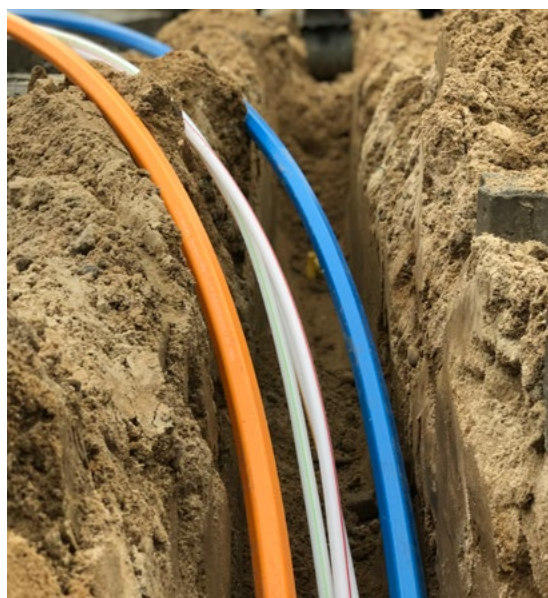
Beispiel für die Verlegung im offenen Rohrgraben
