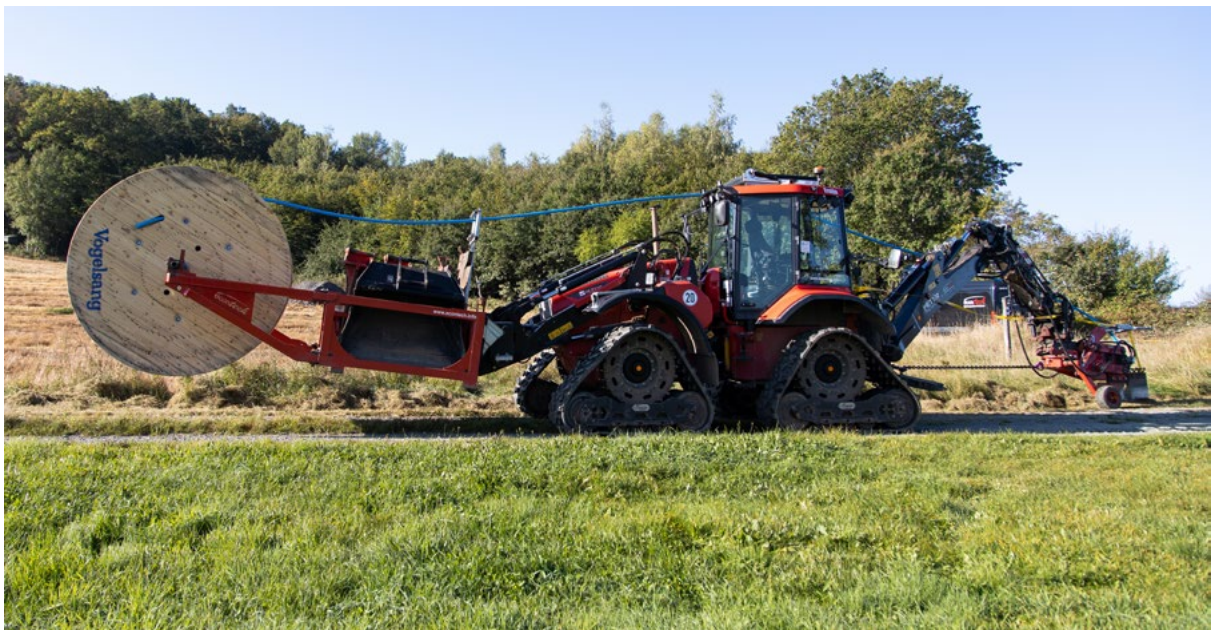
FiberSpeed Verbund im Pflugverfahren: Diese Verlegeart findet häufig im ländlichen Raum Anwendung.
