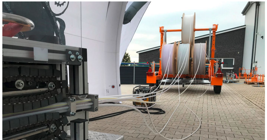
Einblasgerät der Firma Lancier, vorbereitet zum Einbringen von FiberSpeed® 10 × 1,0 mm Monorohren in ein 50 × 4,6 mm Schutzrohr
